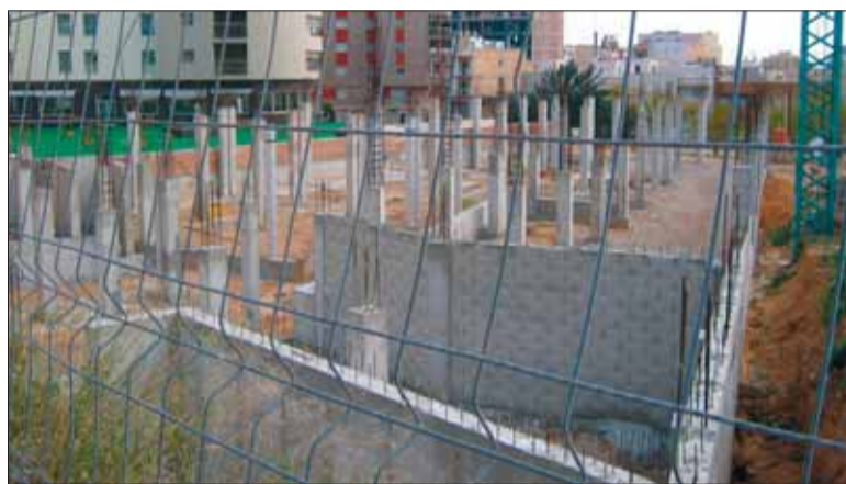
Les obres de la futura biblioteca es reprendran a finals d'any. / S. CABANES
